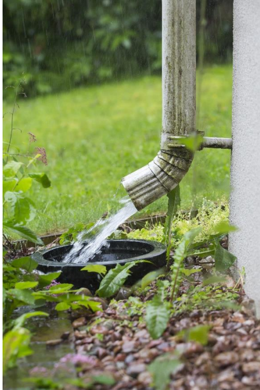
Figuur 65: Afkoppelen dakafvoer van het afvoerstelsel
