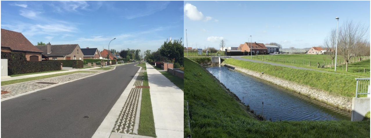
Figuur 67: Links: Lokale infiltratie wegverharding en fietspad; Rechts: Infiltratiebekken
